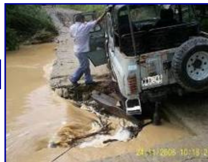
La reconstrucción del puente del río Neme
